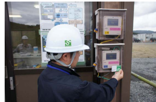
石巻市の応急仮設住宅建設現場における 先行導入模様（平成23本年7月）
